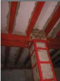
CONSOLIDACIÓN DE ESTRUCTURA
